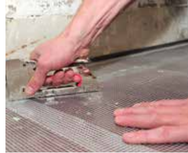
3 Aanbrengen van KÖSTER wapeningsnet op de houten ondergrond
