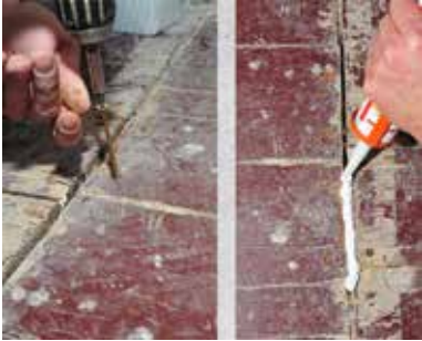
1 Voorbereiding ondervloer: Bevestiging van losse planken en afdichten van oneffenheden
