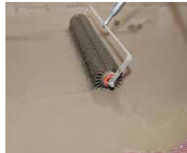
6 Ontlucht tot slot het materiaal met een prikrol
