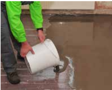
4 Verdeel direct na het mengen (minimaal 3 minuten) in de gewenste laagdikte
