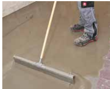
5 De vloeregalisatiemassa wordt met een getande vloerwisser over grotere oppervlakken verdeeld
