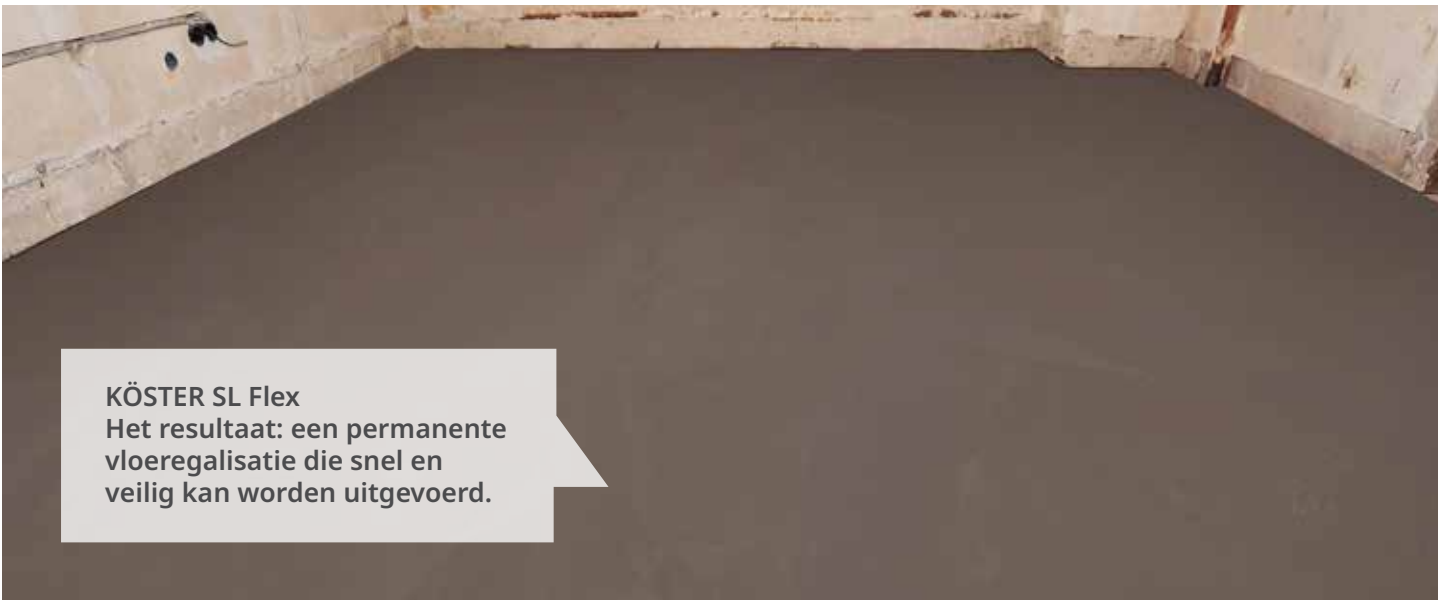
4 Verdeel direct na het mengen (minimaal 3 minuten) in de gewenste laagdikte
