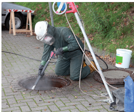
Ondergrond voorbereiding (hier water onder hoge druk)
