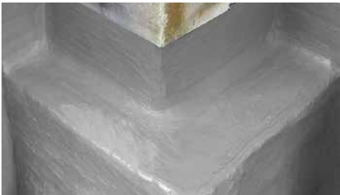
Fundament en kimaafdichting
