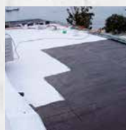
Afdichting op bitu-mendak
