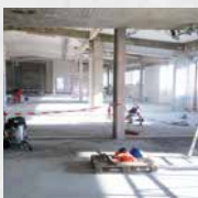
Sanering van pilaren
